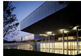
MAST MANIFATTURA DI ARTE SPERIMENTAZIONE Bologna / 2013 Labics Architetti
