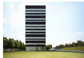
CENTRO DIREZIONALE IMOLA TORRE Imola (BO) / 2008 Lelli & Associati Architettura
