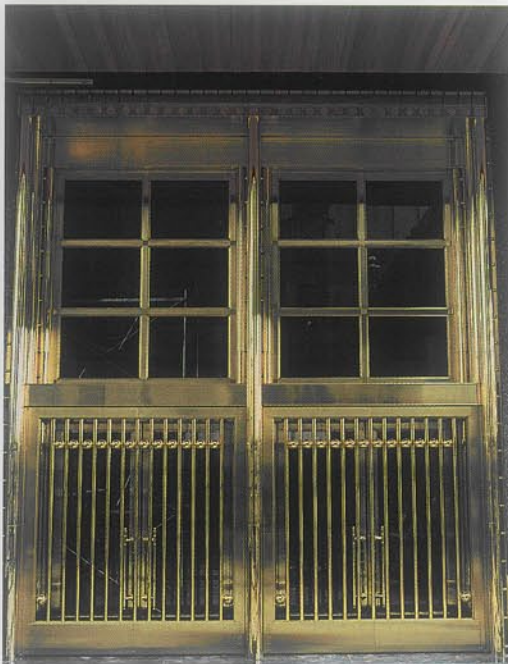
Ingresso eseguito da Italinnox/Castellamare di Stabia (NA)
