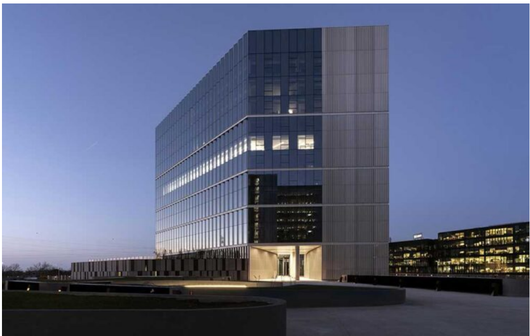
Insieme all'Edificio U3 di GBPA Architects, l'architettura di Park Associati fa parte della destinazione terziaria nel comparto di Milanofiori Nord, ph. ©Andrea Martiradonna.
