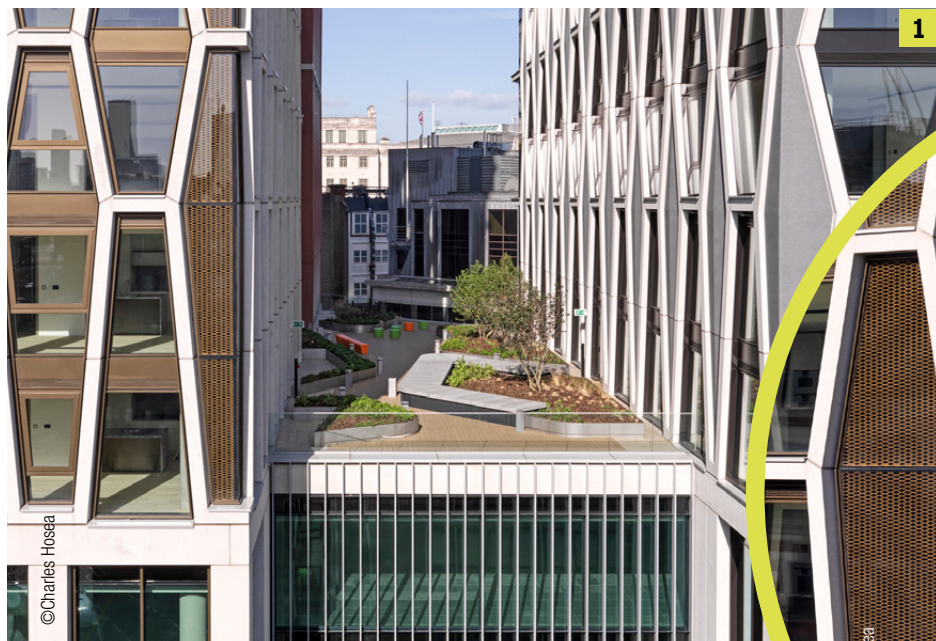
1 Composizione morfotipologica ed espressiva dei sistemi di involucro secondo l'impostazione su segmenti trapezoidali che racchiudono le superfici trasparenti, opache o diaframmatiche
