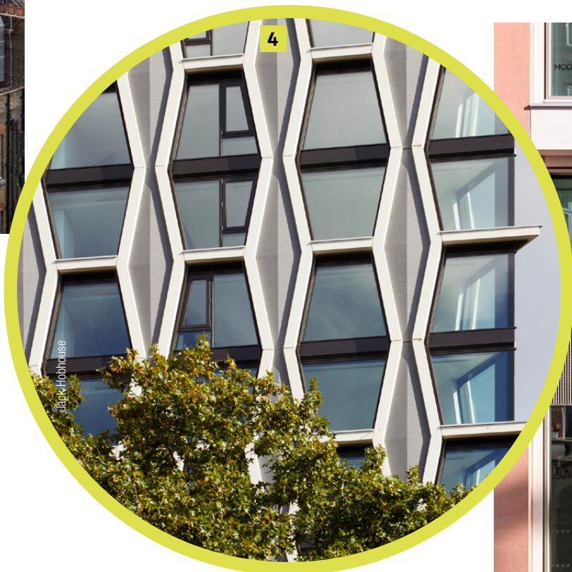
1 Composizione morfotipologica ed espressiva dei sistemi di involucro secondo l'impostazione su segmenti trapezoidali che racchiudono le superfici trasparenti, opache o diaframmatiche
