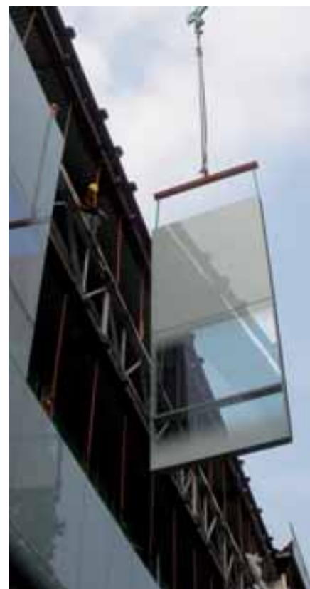
Una fase della posa della facciata continua a cellule indipendenti prodotta dal Gruppo Focchi
